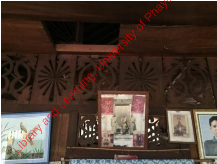
“แผงคอลาย” และแผงไม้ฉลุลายเหนือกรอบประตูทางเข้าห้องนอน
